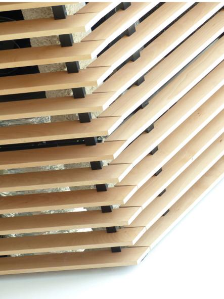
*Dans le cadre du plan de rénovation et de modernisation du Parc des expositions de la Porte de Versailles, nous avons été retenus pour la pose de 1 200m<sup>2</sup> de plafond bois Lauder Liné 20.70.90 en format 1 800 x 600 mm sur une ossature cachée noire avec incorporation de luminaires et trappes de visite invisibles.*
